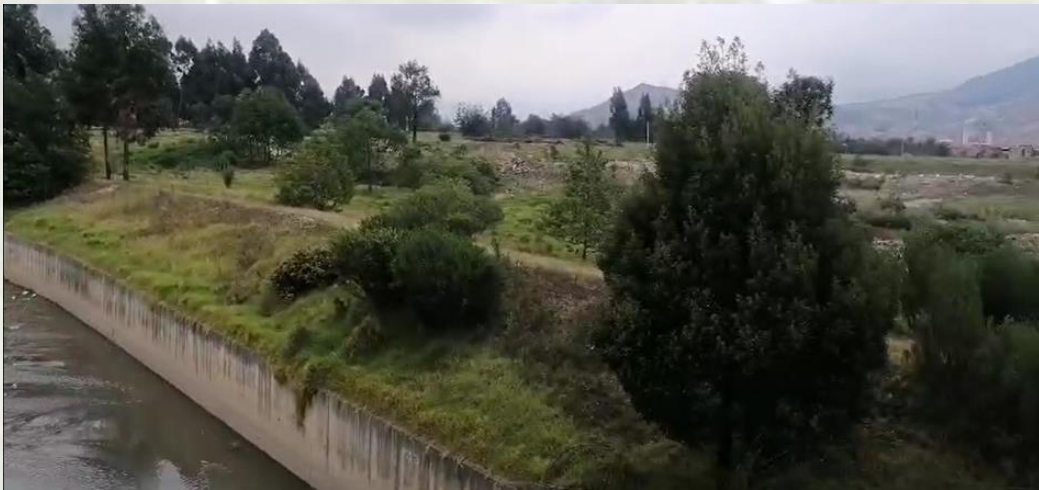
Imagen 4Cruce de la quebrada la Chiguaza con el Río Tunjuelo a la altura del Puente de Meissen
