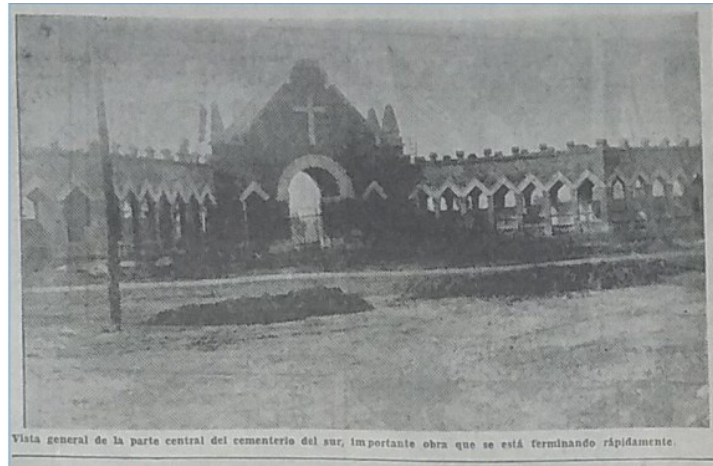
Imagen 4: Vista del frontón triangular coronado de la entrada al Cementerio del Sur, aún en estado de obra, su coronamiento es con pináculos en piedra y almenas en ladrillo a dos aguas. La Secretaría de Obras Públicas Municipales realizó los planos y diseños. Fuente: Periódico El Tiempo, 17 mayo de 1944.
