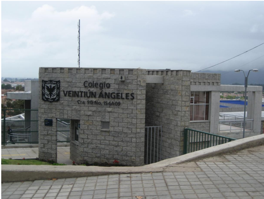
Anexo 5. Registro fotográfico colegio veintiún Ángeles.
