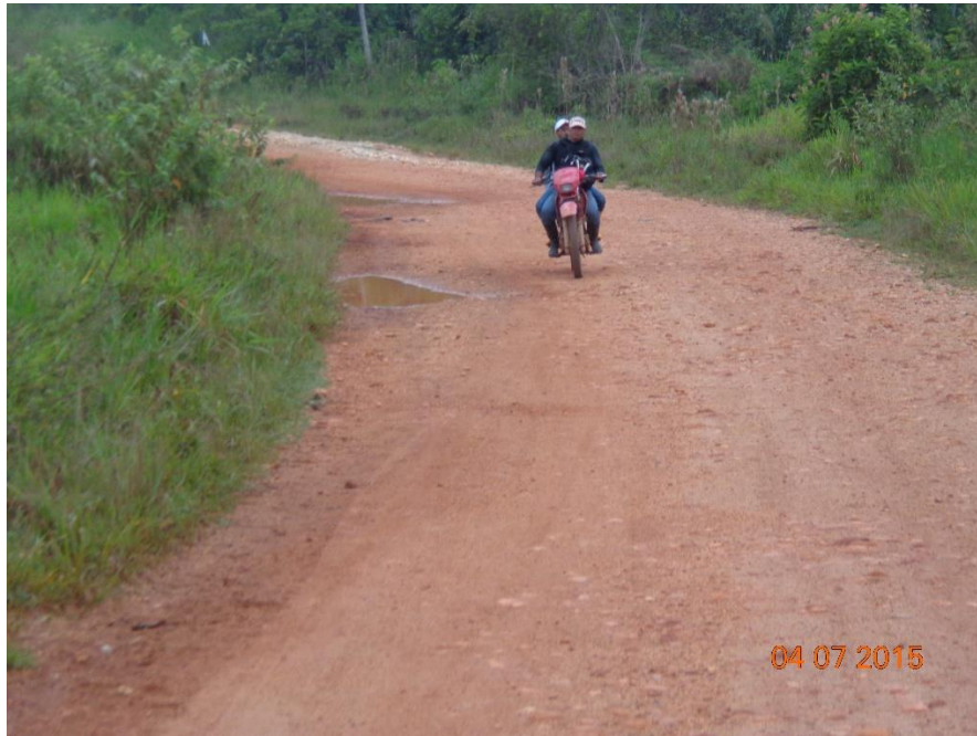
Ilustración 4 Antigua pista de Gacha, en la actualidad se usa como vía.
