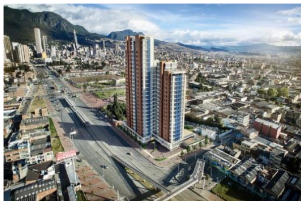
48 Imagen 44. Gallo-Londoño arquitectos (2022) Panorámica en altura edificio Zima 26. Bogotá, 2022. Recuperadode: https://shre.ink/mwql
