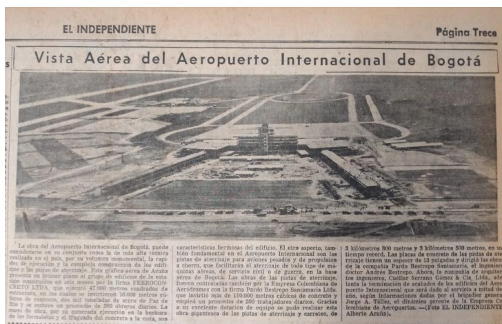
65 Imagen 61. Vista Aérea del Aeropuerto Internacional de Bogotá. Periódico El Independiente (En prensa) 1958-03-04.
