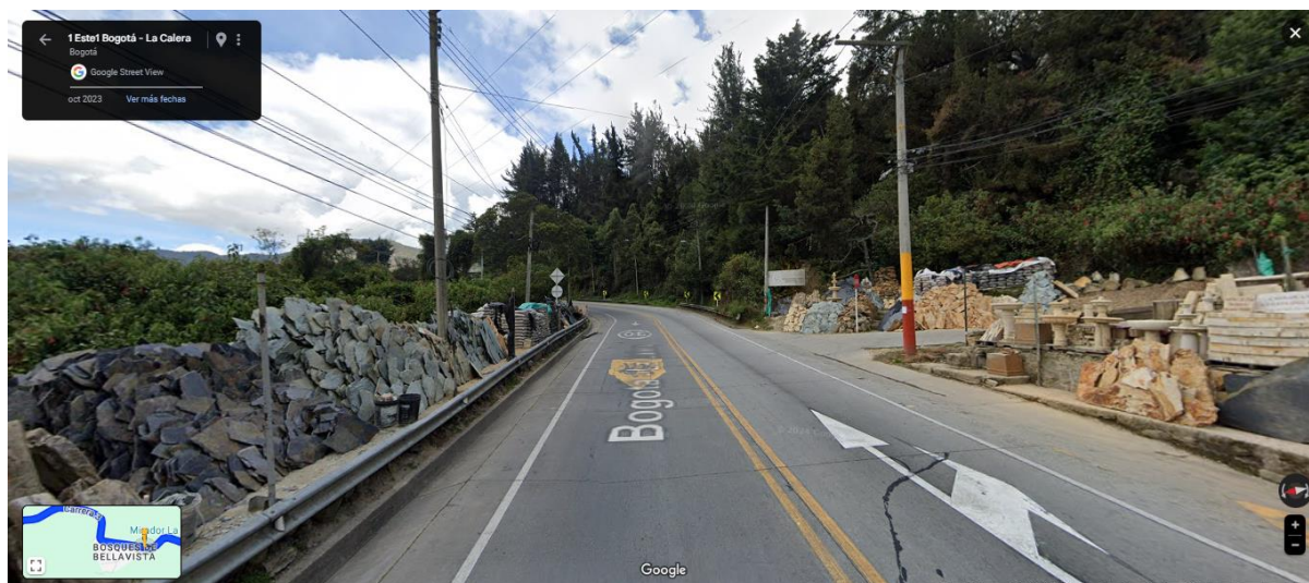
Fotografía 9. Vía Bogotá – La Calera, Finalizando Km 3 Recuperado de Google Maps
