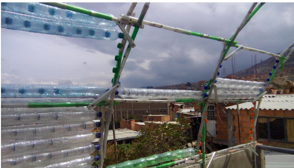
Imagen 11: estructura del invernadero elaborado con botellas desechables de plástico.
