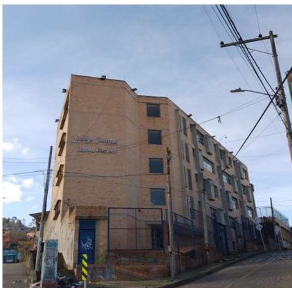
Ilustración 3. Fachada de la Juana Escobar
