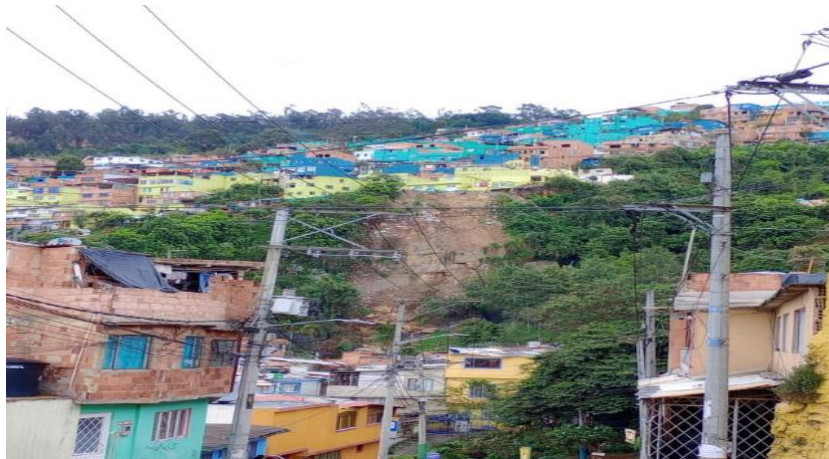
Figura 3: Derrumbe entre los barrios Cerro Norte y Santa Cecilia. Registro propio, mayo 2023.
