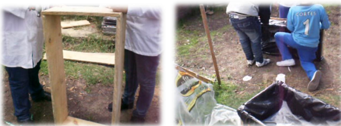
Fotografías 28 y 29. Construcción e impermeabilización de contenedores.
