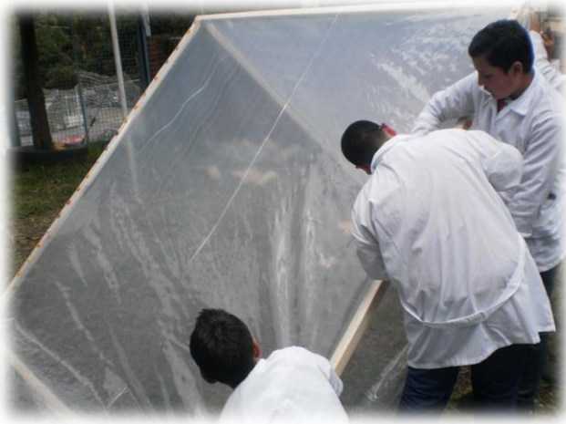
Fotografía 9. Revestimiento con polietileno.
