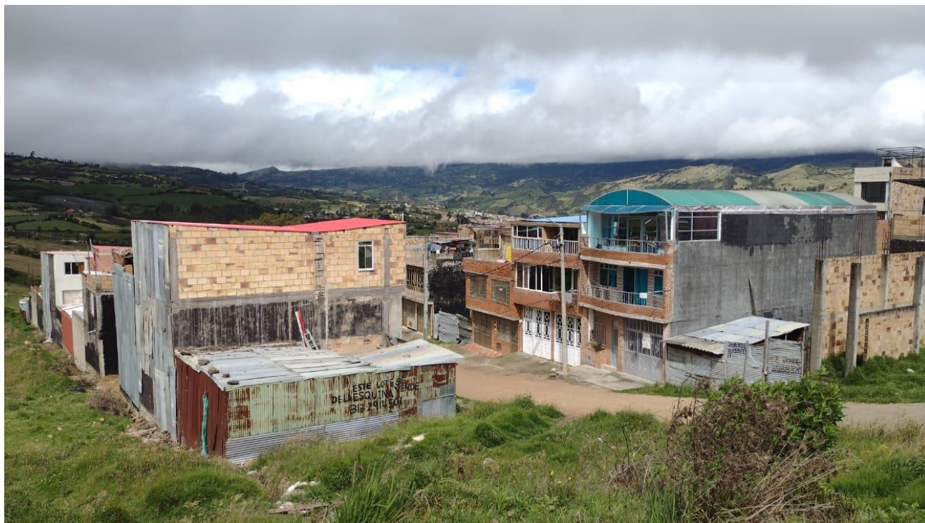
Fotografía 2. Proceso de construcción de vivienda informal-popular. Barrio Brisas del Llano, este es uno de los barrios que queda a inmediaciones con el área rural de Usme.
