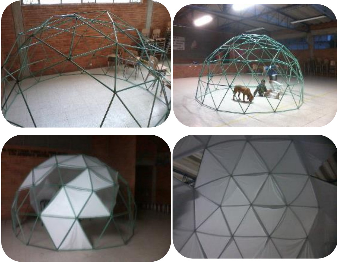
Figura 15: Construcción del domo geodésico.
