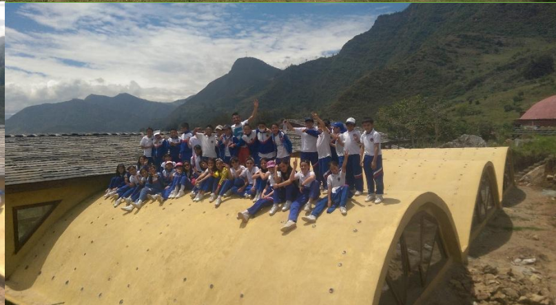
Fotografía 60: Sala, el tejado es hecho a partir de neumáticos que se recortan, y se adhieren entre sí con tornillos, esto posibilita, un techo impermeable, duradero y muy barato.
