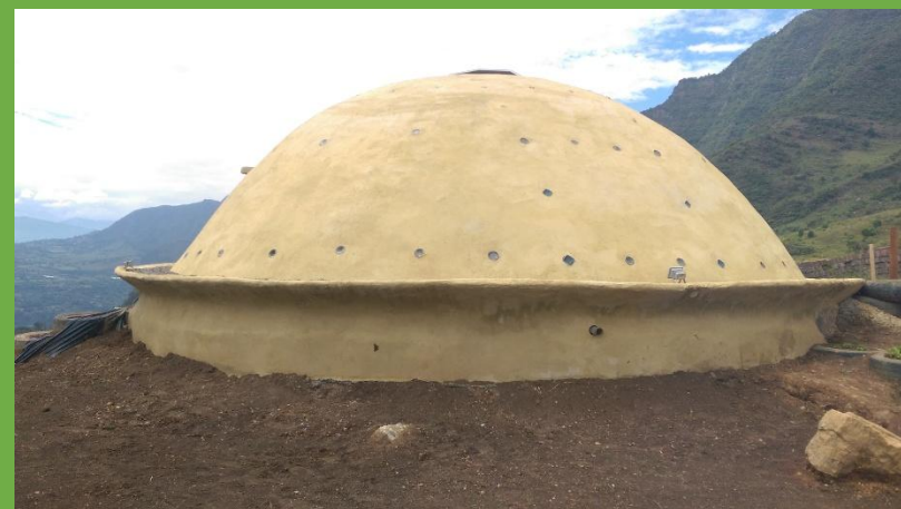
Fotografía 37: Baño seco, normalmente funcionan con aserrín o arena, los desechos después son utilizados como abono.
