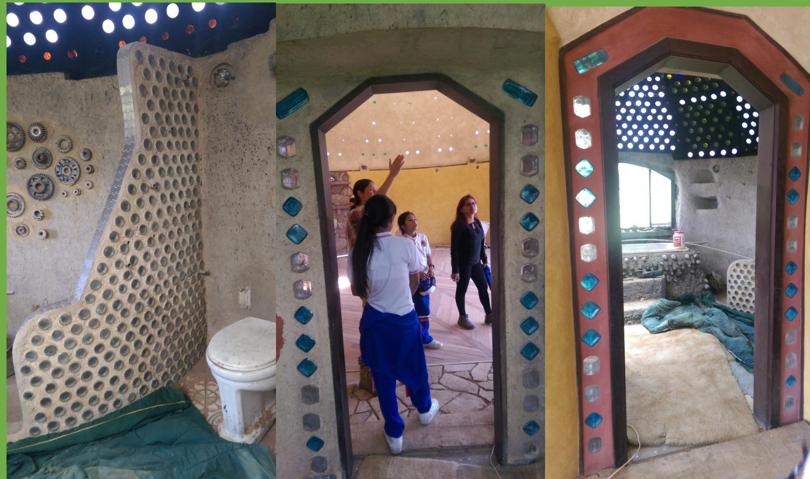
Fotografía 53: Baño, decoración hecho a partir botellas de vidrio y paneles de industrias, piñones utilizados como elementos de adorno, baño de segunda mano.
