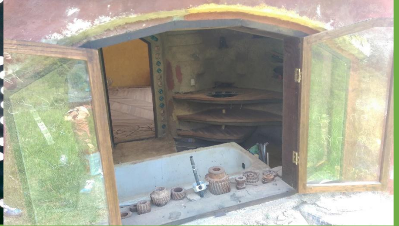
Fotografía 49: Tina de segunda mano, su estructura hecha a partir de botellas de plástico rellenas de basura, que cumplen la función de un ladrillo.
