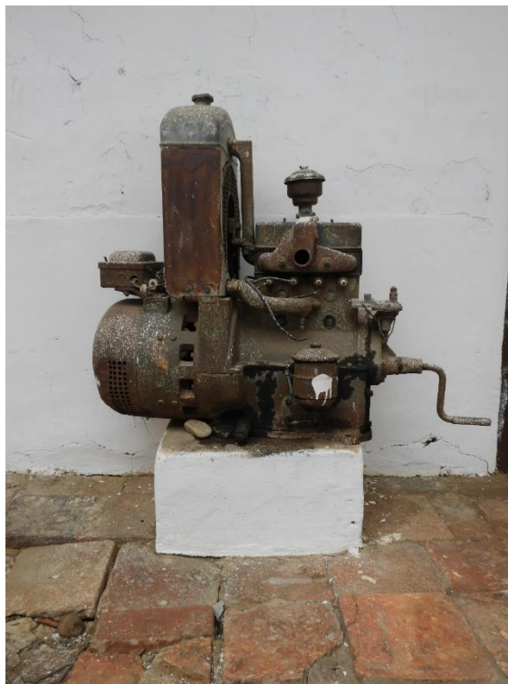
Fotografía 3. Planta eléctrica inicial marca Kohler
