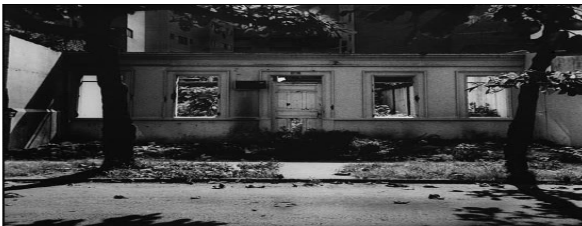
Figura3. Franco, F. (2000).Demoliciones (Fotografía).Cali. Extraído de http://fernellfranco.org/ Ilustración 3 Demoliciones
