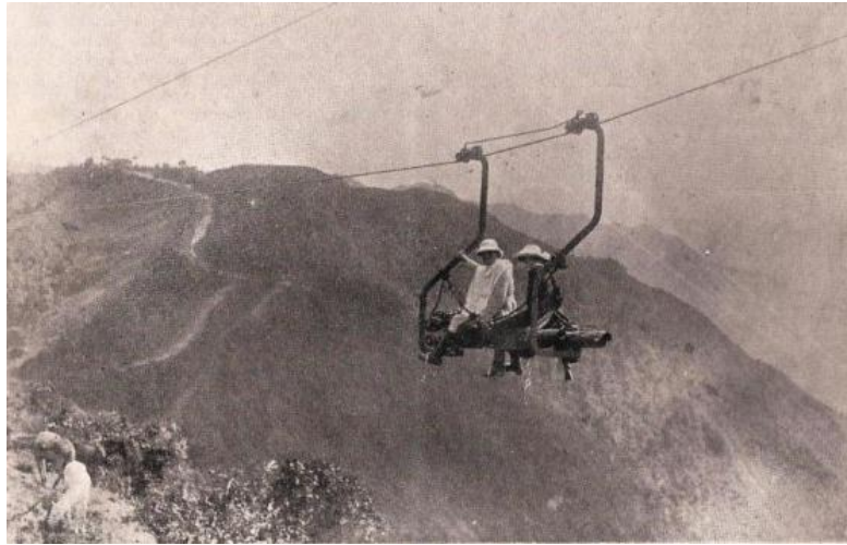
Figura N° 5 Cable aéreo sobre Mariquita
