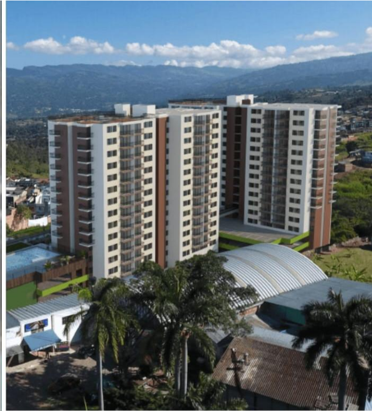
Fuente: Constructora Niidos, 2025.
