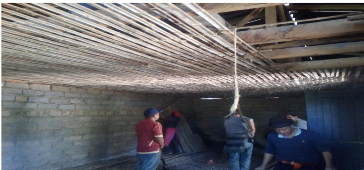
Ilustración 32. Construcción de la casa. Fuente Elías Tumiña, 2024
