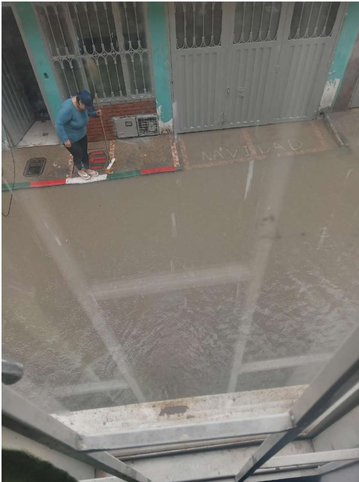
Anexo AA Inundación en la cuadra.
