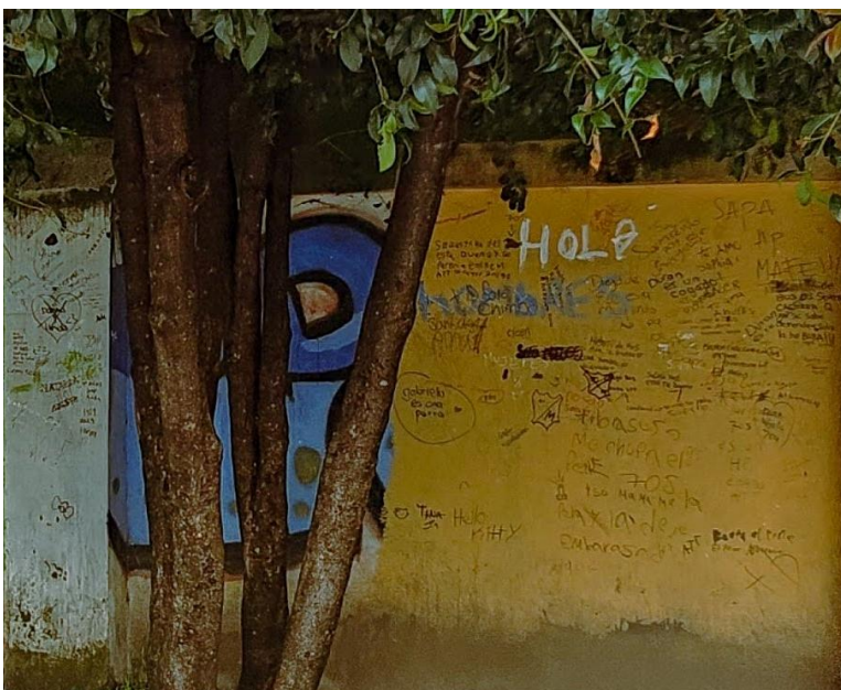
Fuente: Pinta de color azul que ha sido cubierta por una capa de pintura naranja. Fotografía propia Alejandro Theran, 2025.
