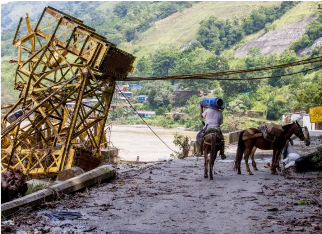
Fuente: La razón. (2018). Destrucción del puente Simón Bolívar en Puerto Valdivia posterior a la Emergencia de HidroItuango.
