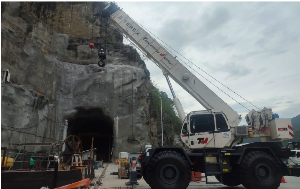
Fotografía 9. Zona de trabajo para la expansión de HidroItuango.
