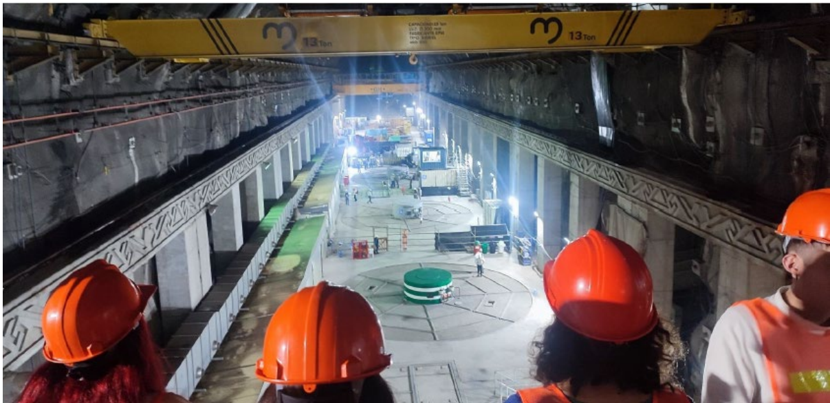
Fuente: Estudiantes en salida de campo del seminario Problemas Actuales de América Latina (2023). Cuarto de máquinas de la hidroeléctrica HidroItuango.
