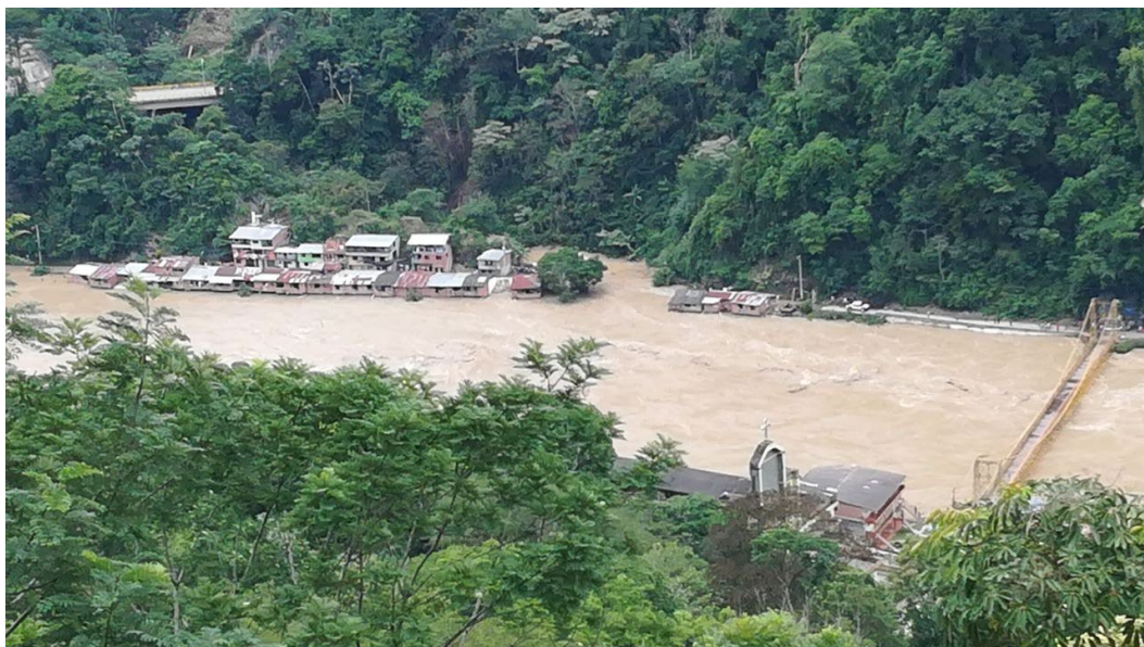
Fuente: La razón. (2018).Foto panorámica de la inundación de Puerto Valdivia.
