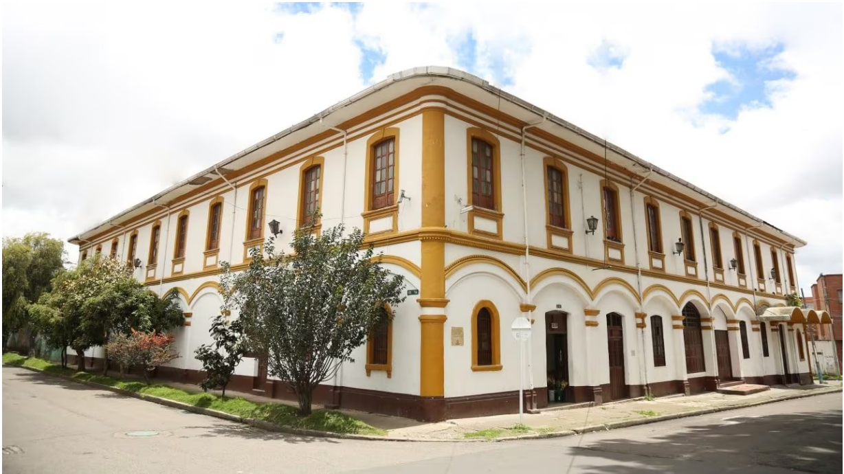
FIGURA 20ª: CAJA DE OBREROS DEL BARRIO VILLA JARVIER FUNTE: Alcaldía de San Cristóbal
