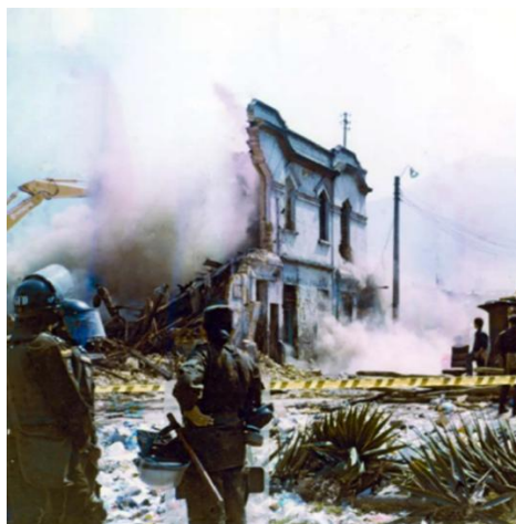
Figura 9: Demolición y construcción de parque Tercer Milenio.
