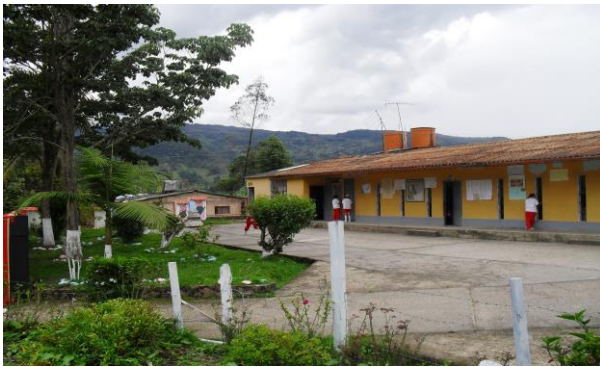
Foto No. 7: Panorámica de la sede de Montejo, frontal
