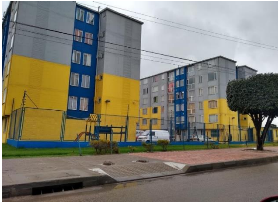
Imagen 33. Conjunto residencial de la Ciudadela El Recreo con reforzamiento en su encerramiento.
