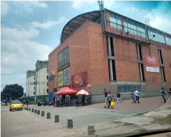
Imagen 22. Centro comercial Metro-Recreo costado suroriental.
