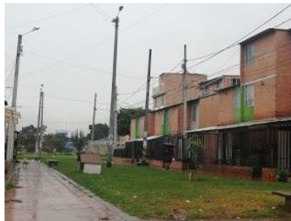
Imagen 32. Vivienda de la Ciudadela El Recreo con modificaciones en su antejardín.
