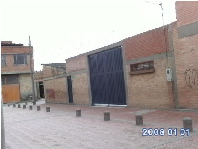
Colegio I.E.D.I.T Rodrigo de Triana, Costado Suroccidente Sede B.
