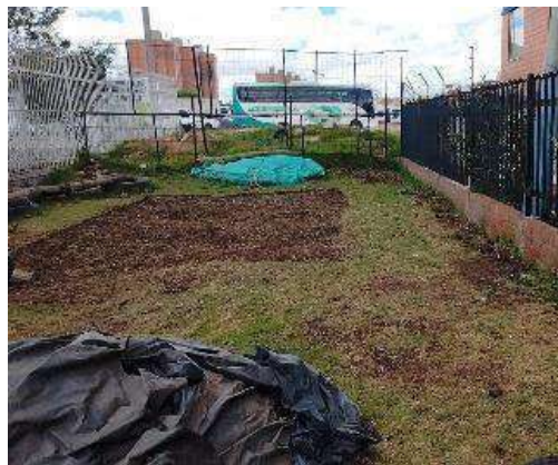
Figura 13: Espacio seleccionado junto con la adecuación de la tierra.
