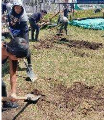
Figura 12: Adecuación del terreno para la ubicación de la huerta
