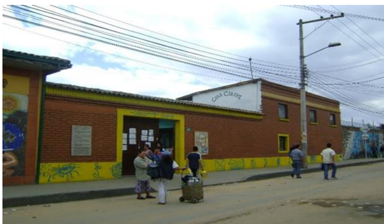
Figura 1. Vista exterior de la Casa Claret
