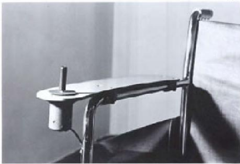
Figura 7 primer joystick silla de ruedas eléctrica archivo del NRC
