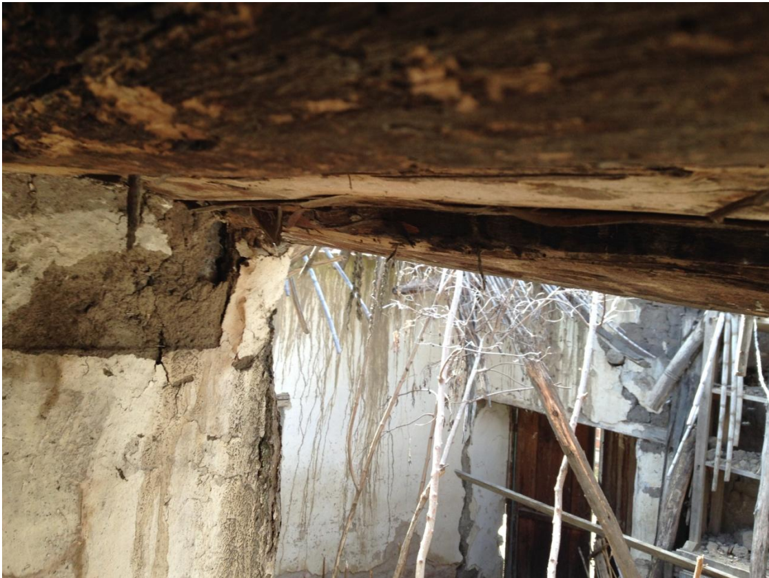
Foto # 35. Etna Castaño Giraldo. Casa Abandonada (Detalle). Aquitania-Boyacá. Enero de 2014.
