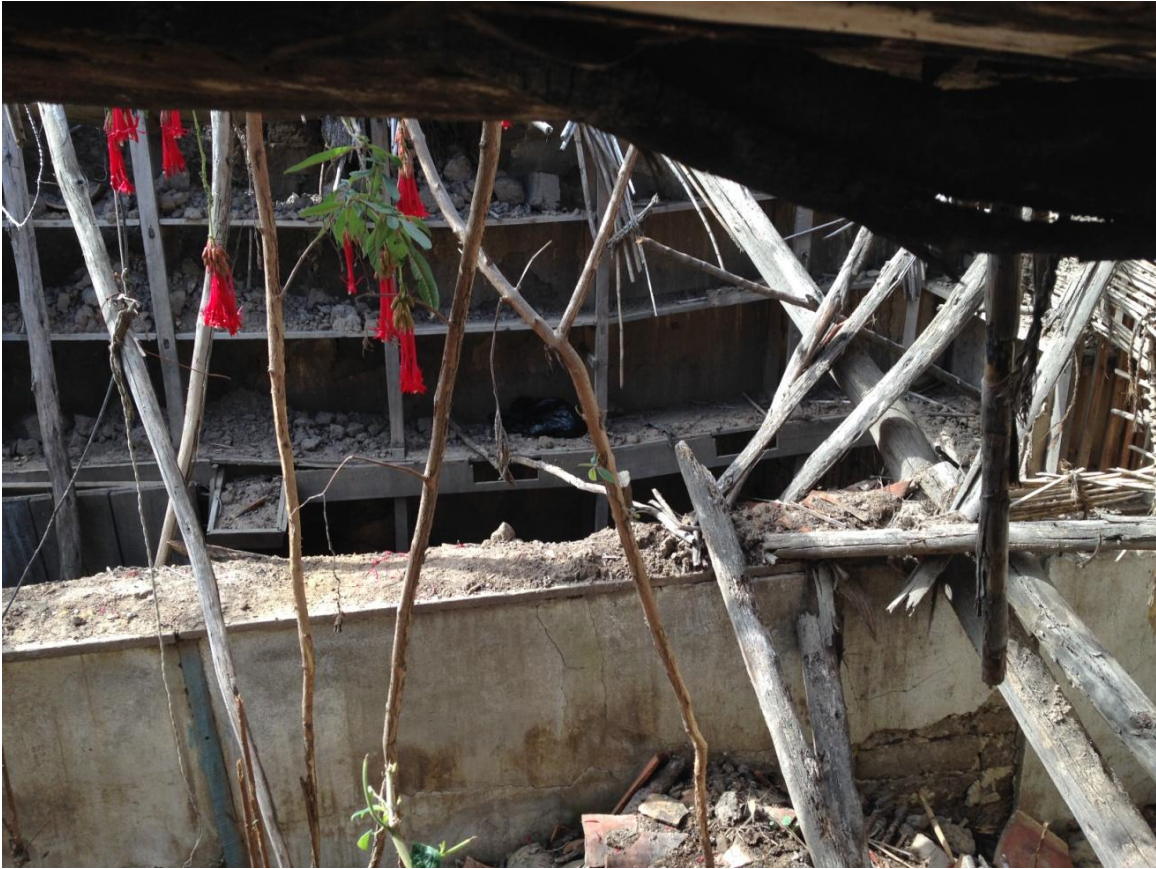
Foto # 32. Etna Castaño Giraldo. Casa Abandonada (Detalle). Aquitania-Boyacá. Enero de 2014.
