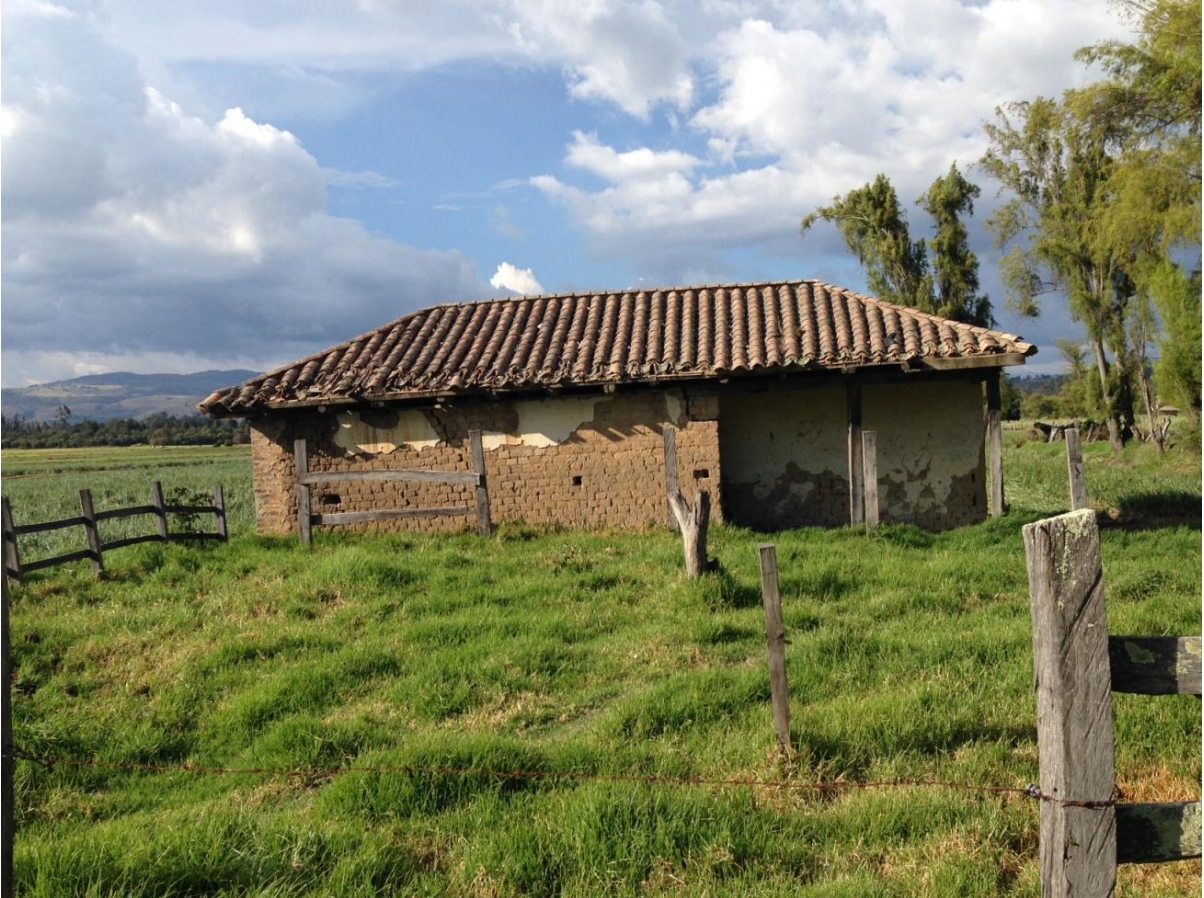
Foto # 14. Etna Castaño Giraldo. Casa Abandonada. Iza-Boyacá. Enero de 2014.
