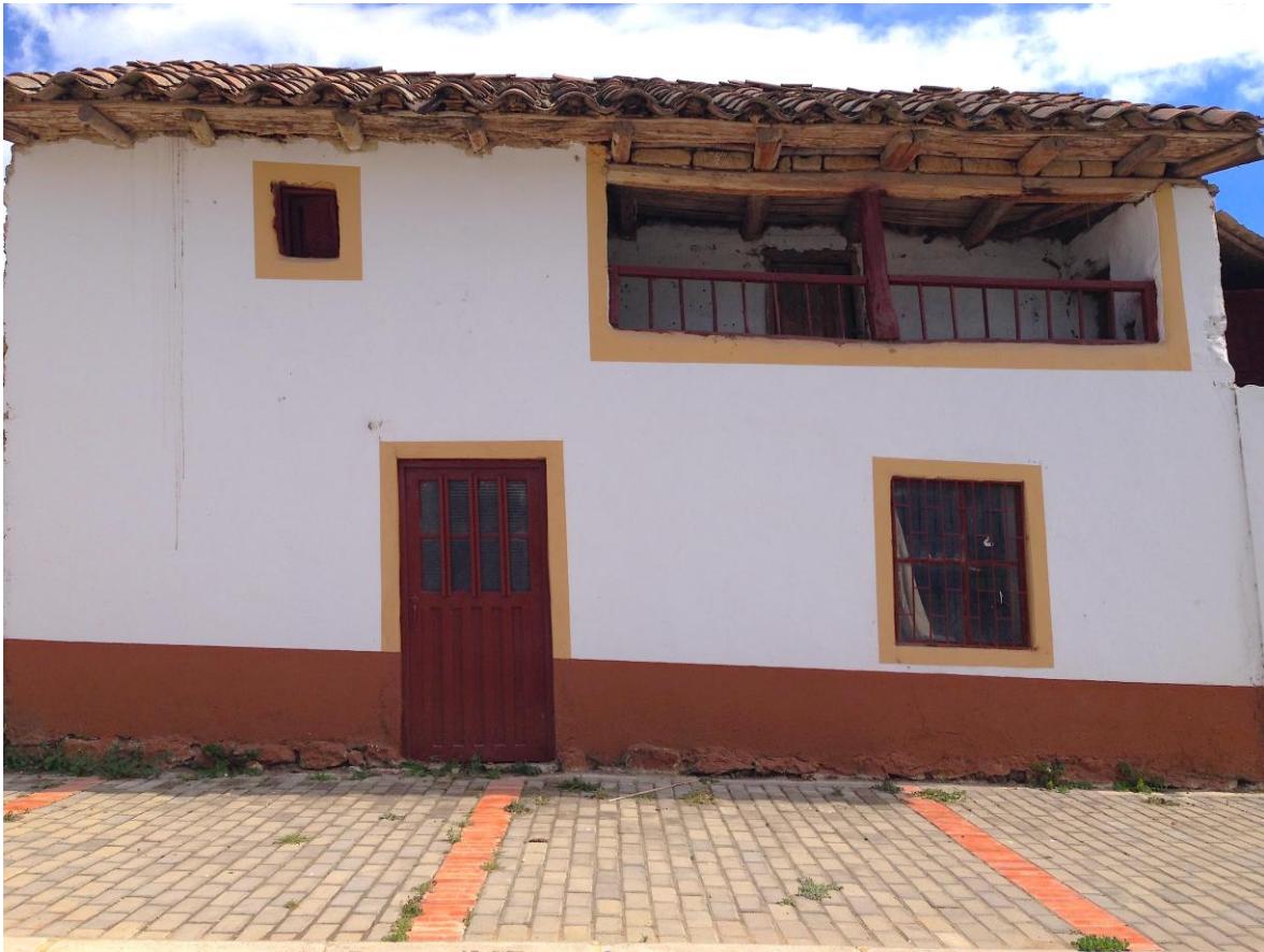
Foto # 20. Etna Castaño Giraldo. Casa Abandonada. Cuitiva-Boyacá. Enero de 2014.
