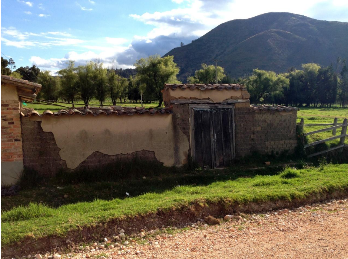
Foto # 43. Etna Castaño Giraldo. Casa Abandonada. Iza-Boyacá. Enero de 2014.
