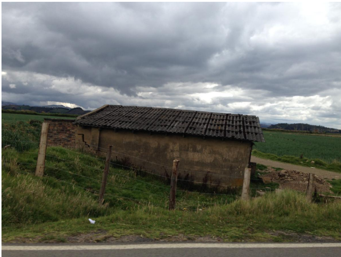
Foto # 48. Etna Castaño Giraldo. Casa Abandonada. Paipa-Boyacá. Abril de 2014.
