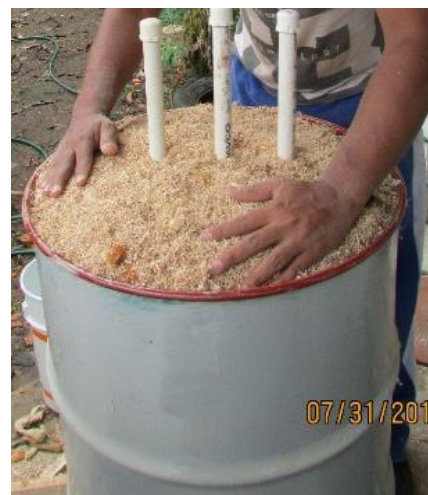
Figura 22. Construyendo el Termo tanque
