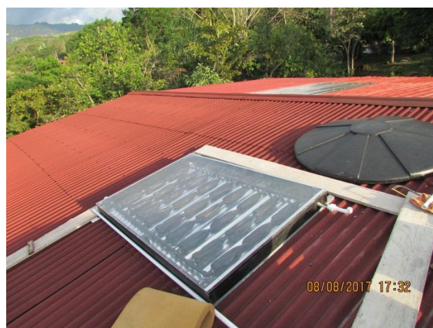
Figura 31. Instalación del colector en el techo
