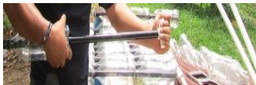
Figura 18. Corte de tubería PVC para armar el colector
