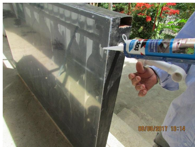
Figura 30. Sellado con silicona
