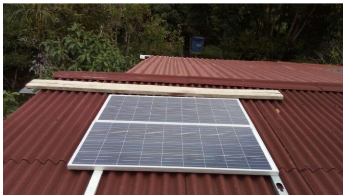
Figura 42. Instalación paneles en el techo
