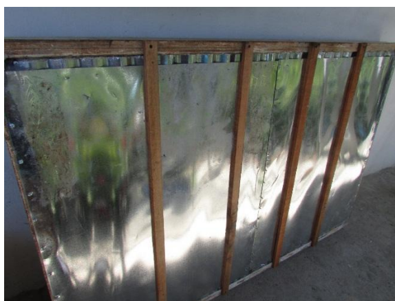
Figura 25. Inserción lamina reflectante
