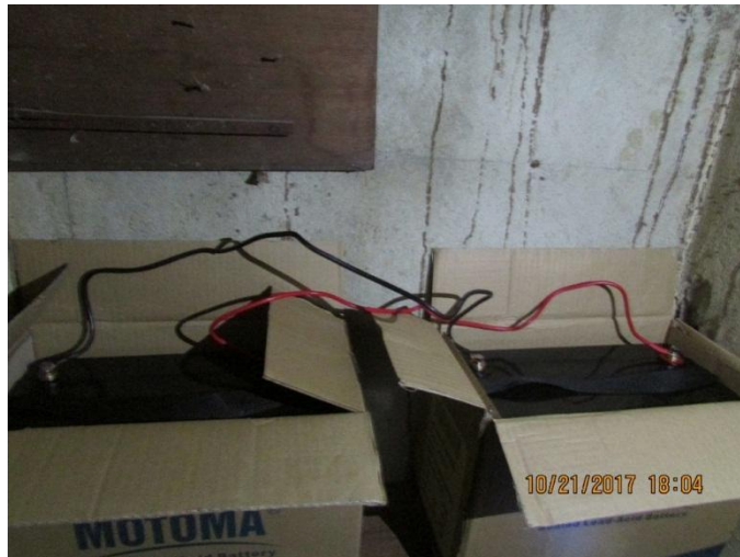
Figura 41. Instalación baterías en paralelo
