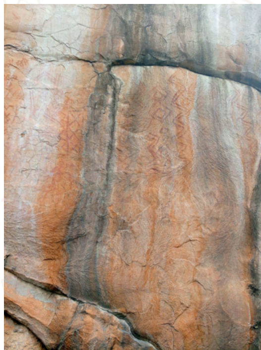
Afectación por escorrentías.
