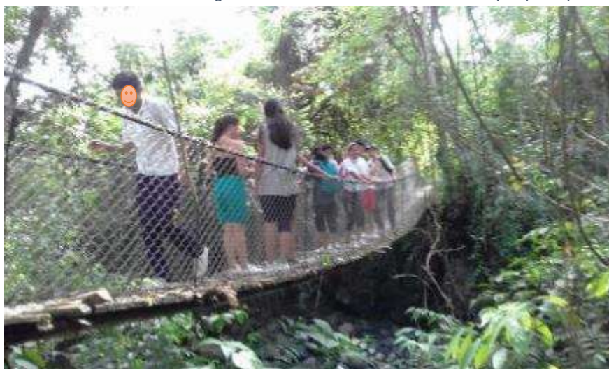
Ilustración 20 Puente Colgante Quebrada Terama - Fuente Propia (2019)
