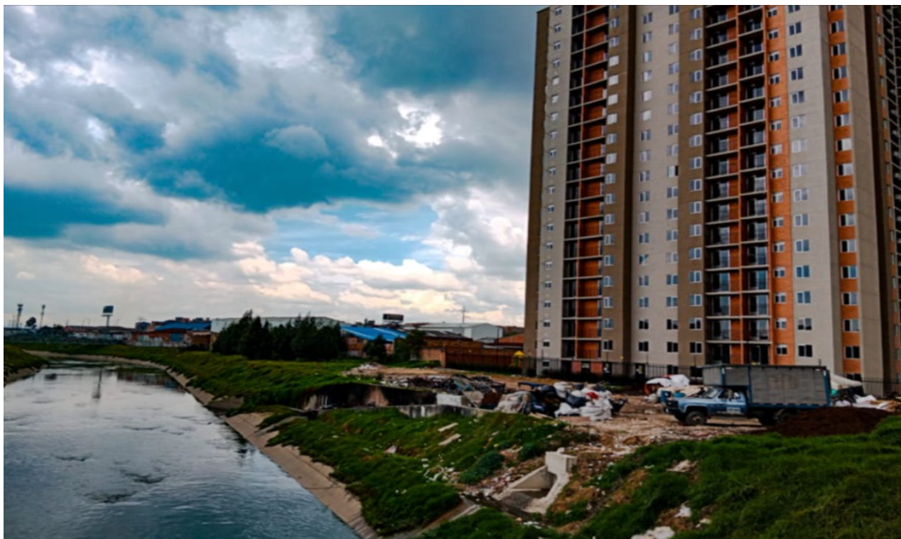
figura 16 Entre la renovación urbana y la injusticia ambiental. Fuente: Elaboración propia.
