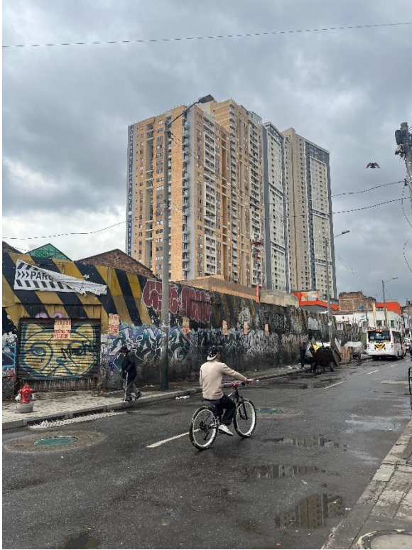
Imagen 10 esquina calle 13 con carrera 17
