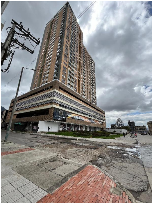
Imagen 15 Calle 15- torres Sabana Central
