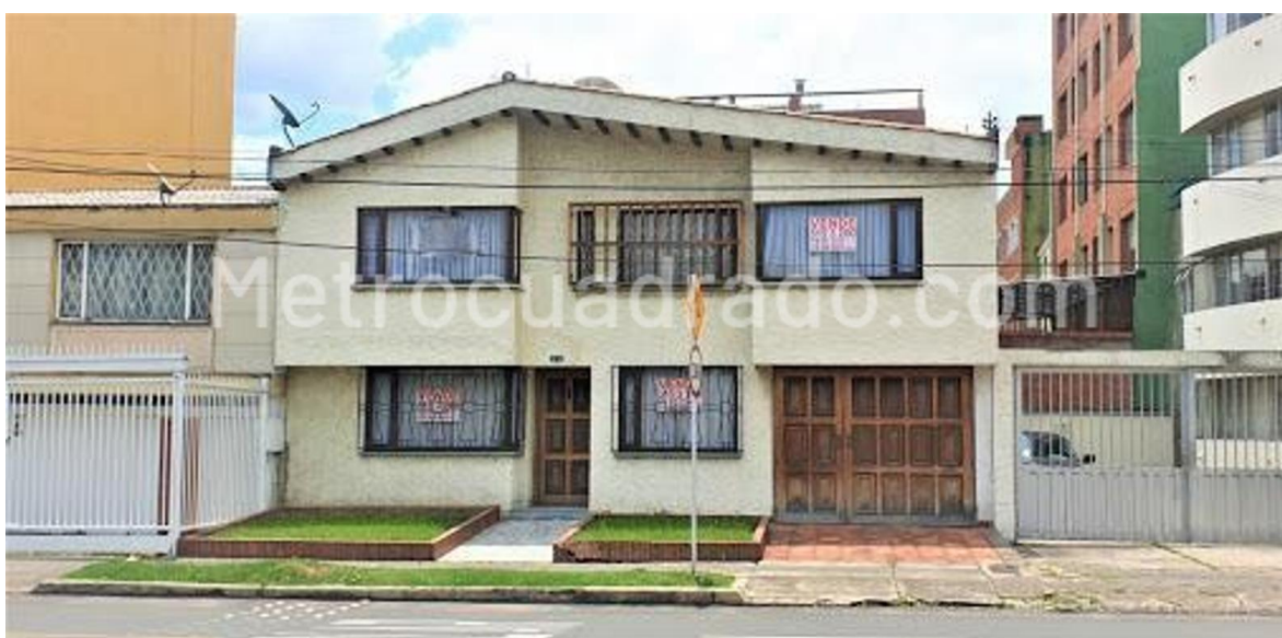
Vivienda 2: ubicada en la Calle 58 # 47 Fuente: https://www.metrocuadrado.com/inmueble/venta-casa-bogota-nicolas-de-federman-5-habitaciones-4-banos-3-garajes/633-1577
