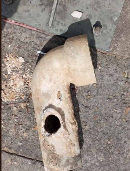
Figura 7: Fotografía de un tubo de cañería encontrado durante en la calle trece (2024).
