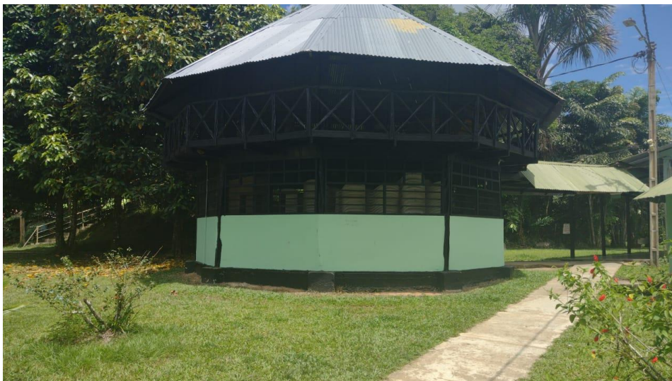
Imagen 77: Mural cubierto de pintura (Abreo, 2021)
