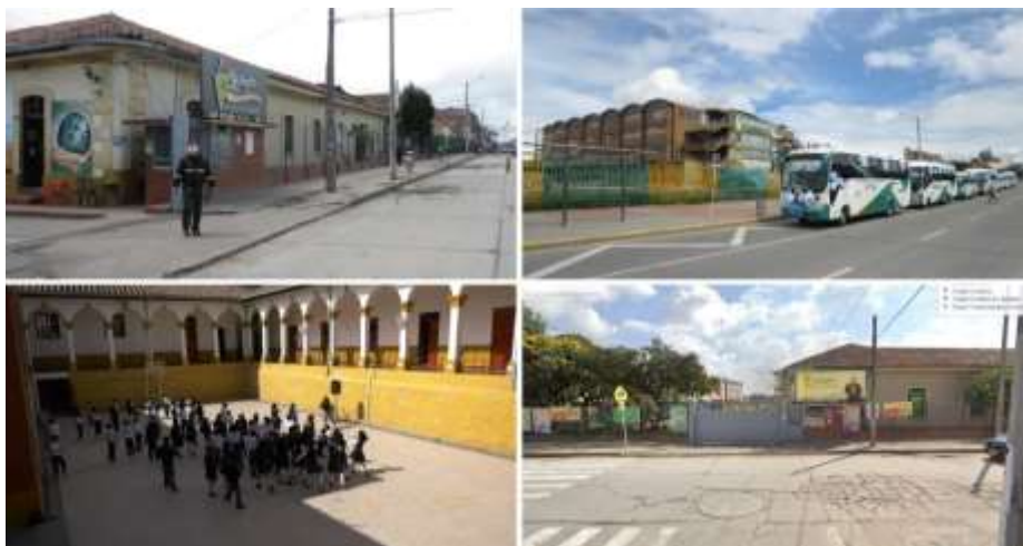
Figura 4. Instalaciones del colegio Claretiano de Bosa
