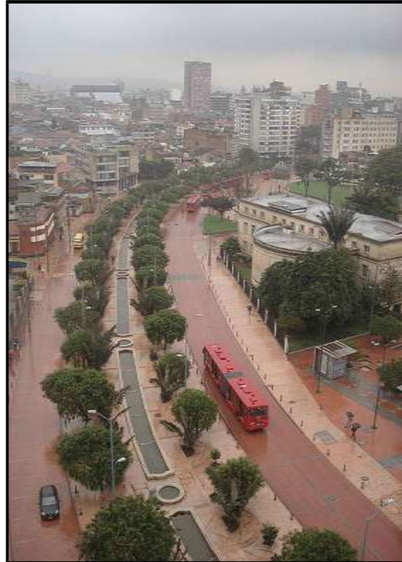
Imagen N° 7. Eje Ambiental Avenida Jiménez. Como representación del río San Francisco que se encuentra canalizado y pasa por debajo él. Foto tomada de
