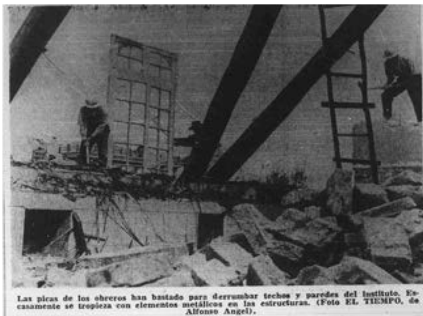
Figura 15. Fotografía de la demolición del Antiguo Palacio de Chapinero
