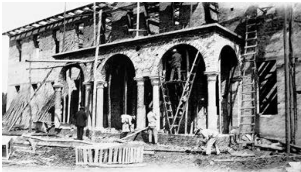
Figura 4. Construcción del edificio principal del Gimnasio Moderno en 1918
