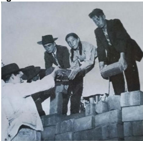
Figura 36 Construcción de la escuela
