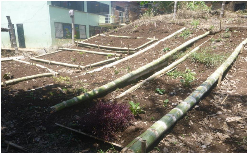
Figura 27. Aspecto de la huerta cuando se estaba construyendo
