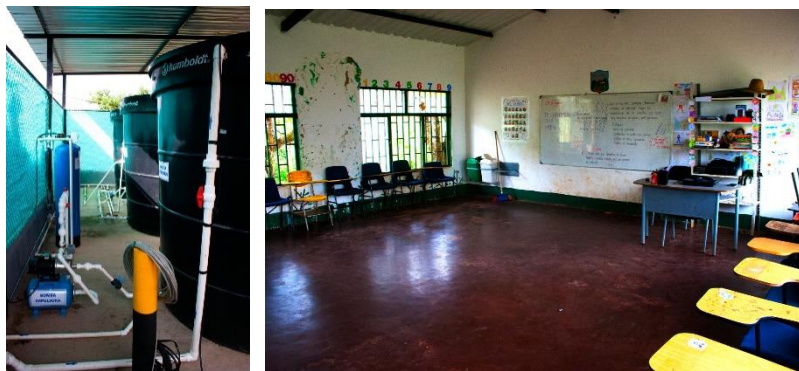
Infraestructura del La Institución Educativa Internado la Esmeralda
