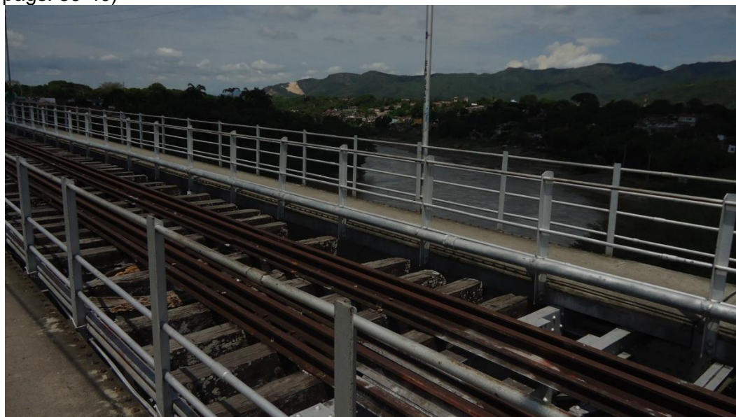
(Puente ferroviario de Girardot sobre el rio Magdalena, Girardot, 15 de abril de 2015, fuente propia) 35
