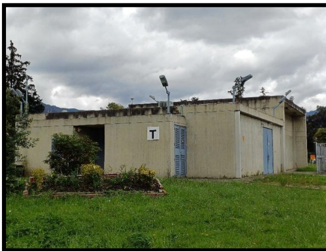
Figura 7: Instalación Centralizada para la Gestión de Desechos Radiactivos
