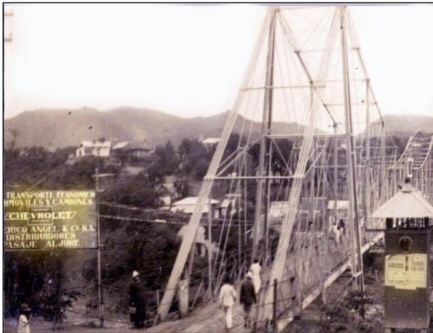
Figura 8: Construcción del Puente de Girardot
