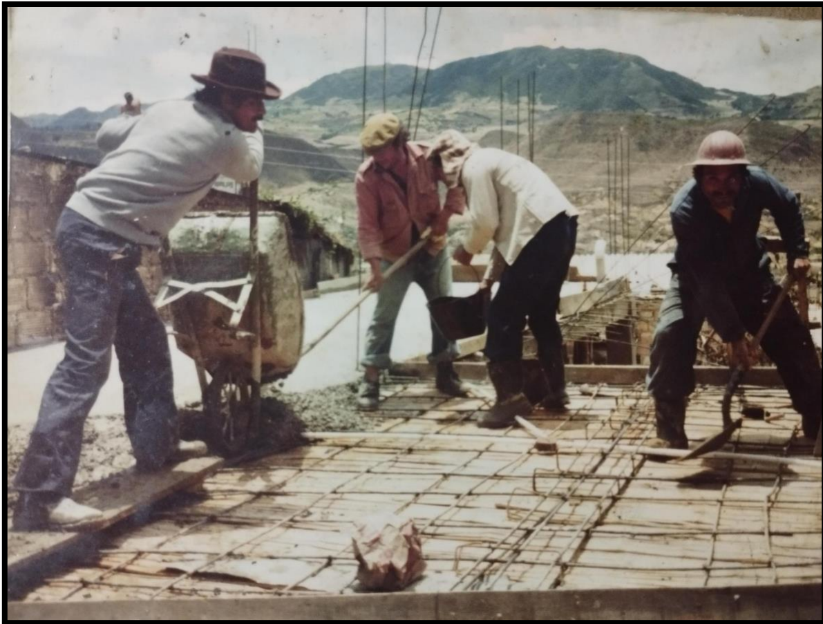
Evidencia fotográfica #6. Año 1985, construcción de la plancha primer piso.
