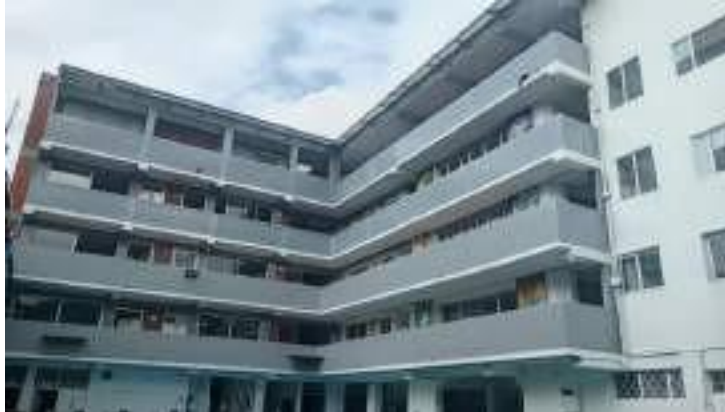
Figura 19 Edificación del colegio
